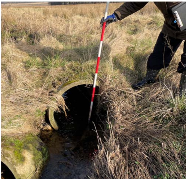
Figur 6 - Røroverkørsel i st. 763-766
